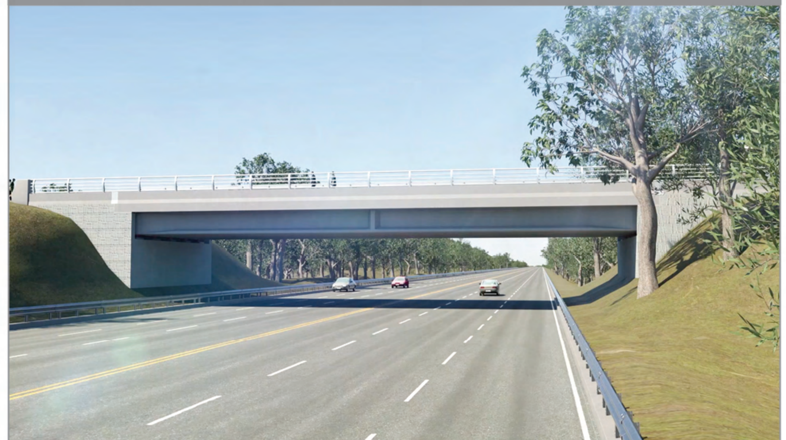
STEP 8 _ 포장 및 부대시설 설치
